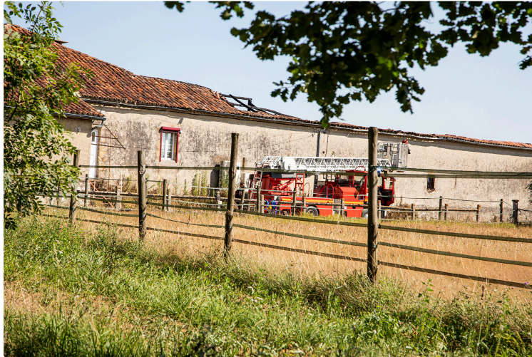
300 m2 d'un bâtiment abritant des chambres d'hôtes détruits par un incendie à Lanne-Soubiran
