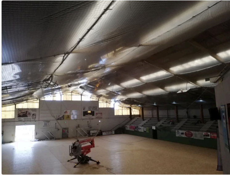
Un chantier impressionnant démarre
