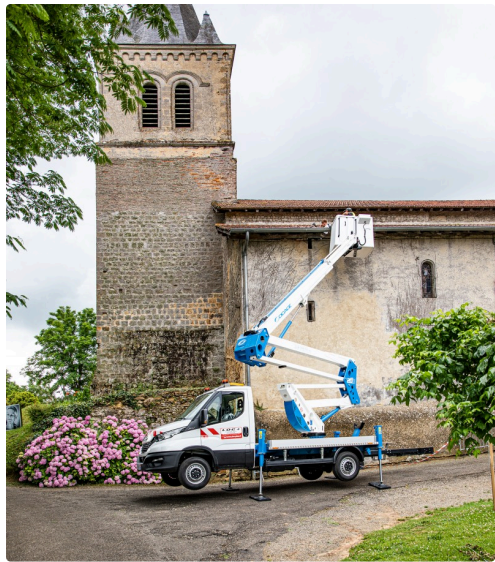
Réfection du toit de l'église de Sainte-Christie
