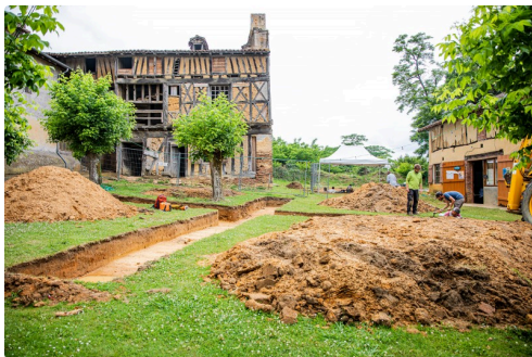
Vue du chantier
