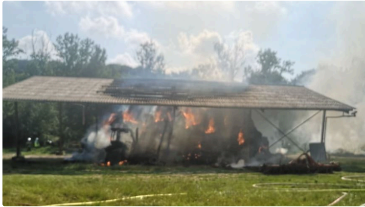
Un incendie détruit un bâtiment agricole de 500 m2
