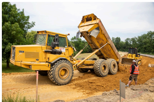
Remblayage pour le voie supplémentaire tourne-à-droite vers l'entreprise
