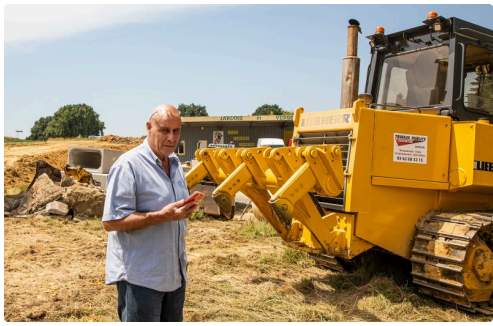
Jean-Marie Verrier sur le chantier
