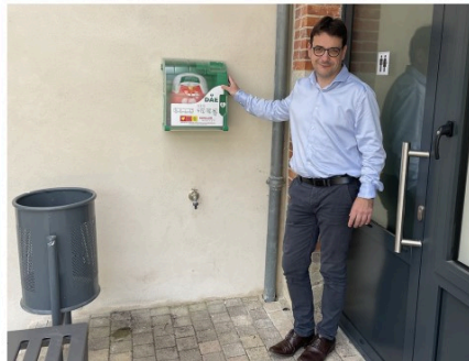
Installation d'un défibrillateur à la salle des fêtes
