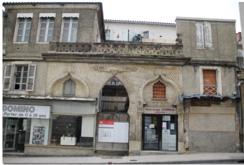
Cot  rue Gambetta un style remarquable qui sera bien s r restaur 
