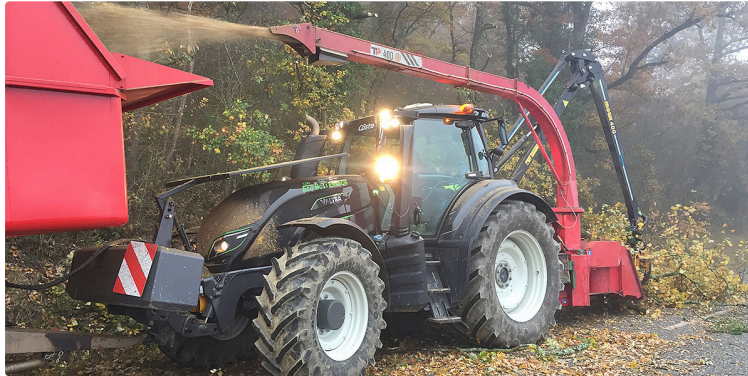
Travaux d'élagage sur la RD 929
