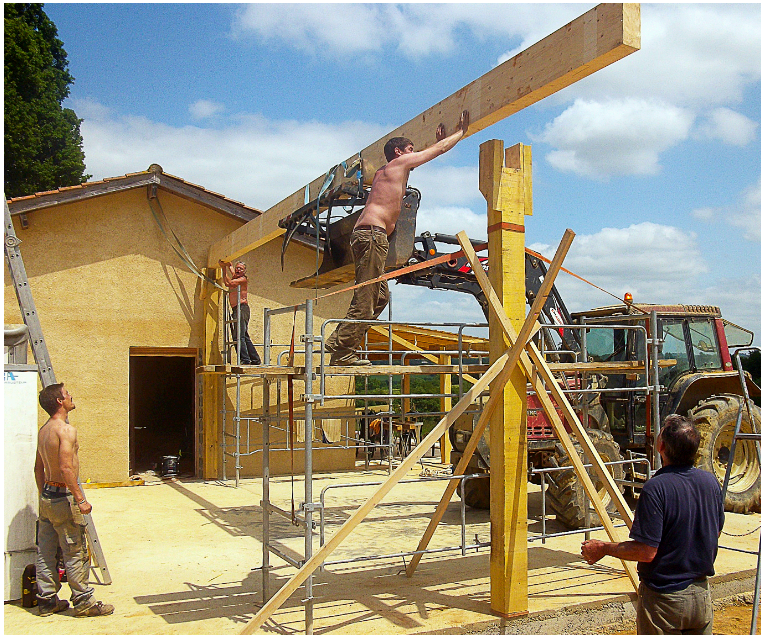
Construction de la "cantina" en 2016 (photo communiquée par Jeff Vayrac)
