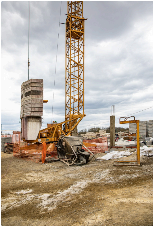
Le chantier le 18 mars
