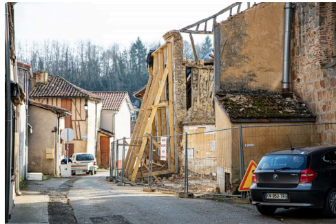
Le chantier n'est pas terminé
