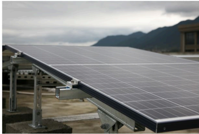
Des parkings ombragés autour du gymnase grâce au photovoltaïque
