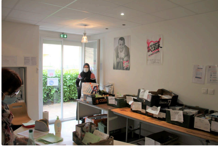
Un faux-plafond pour les Restos du Coeur
