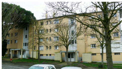
Les bâtiments B, C, D, G, H, et R seront déconstruits.
