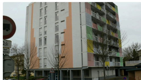
La tour A sera déconstruite.
