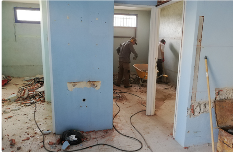
Tennis club : les travaux avancent
