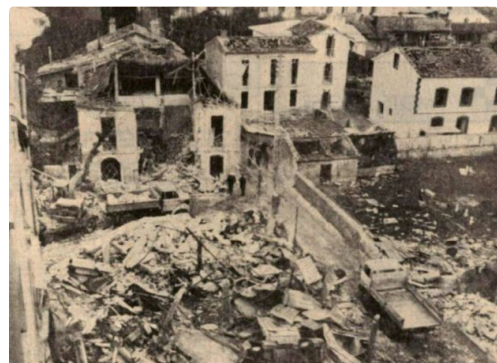
L'immeuble détruit par l'explosion. © Crédit photo : André Vigneau.
