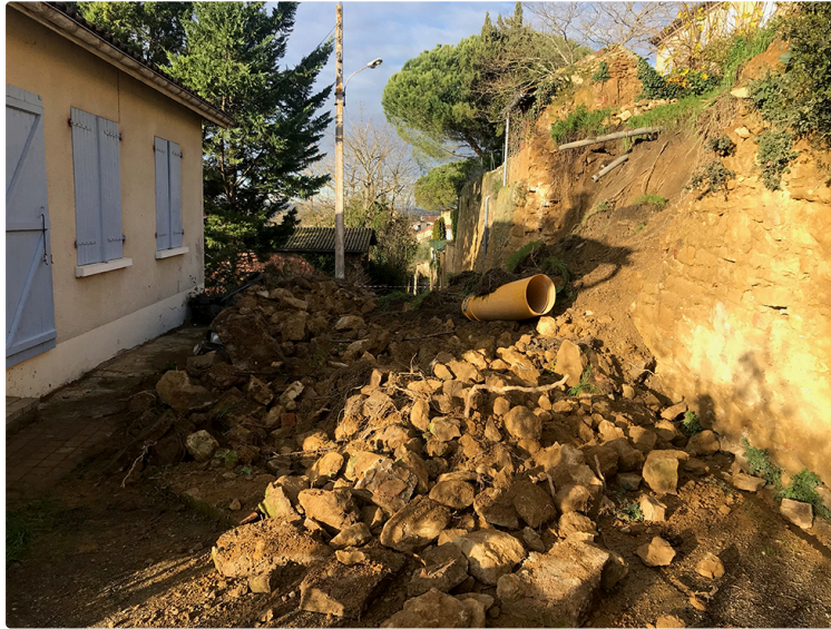
Violent incendie au Garros à Auch. Montesquiou, effondrement d'un mur de soutènement.
