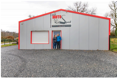
L'atelier de Régis Cellier à la ZAC des Deux-Ponts...
