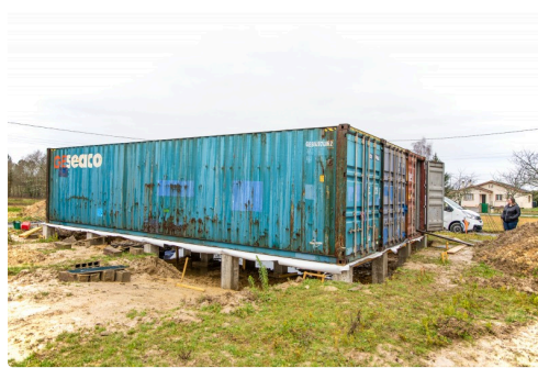
Le chantier sous un autre angle
