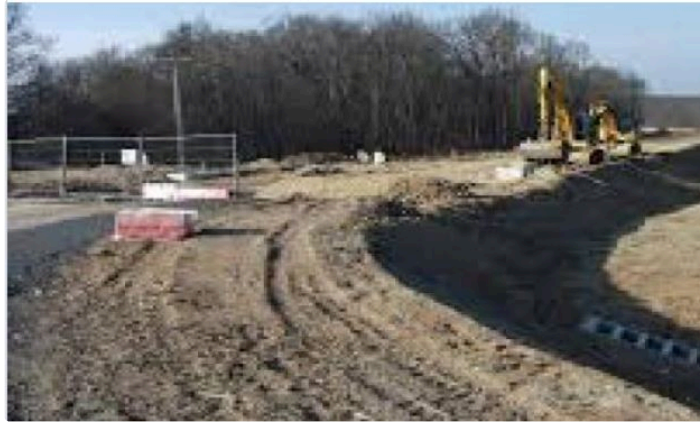
RN 124 : des crédits supplémentaires pour le chantier de la déviation de Gimont
