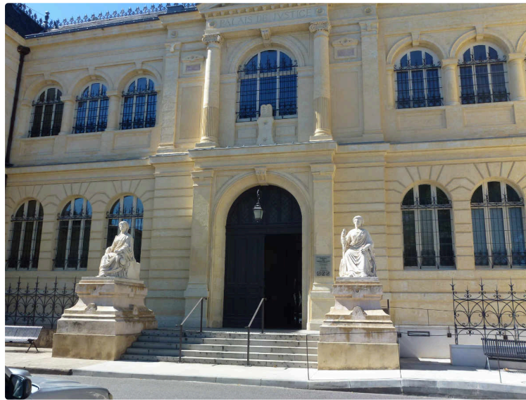
France Relance : la rénovation énergétique des bâtiments de l'État
