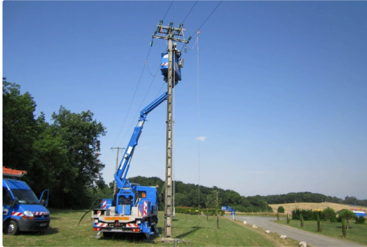
ENEDIS modernise son réseau électrique
