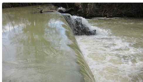
Le canal de déviation de la Baïse
