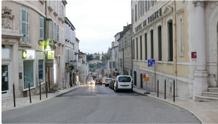
Travaux rue d'Etigny
