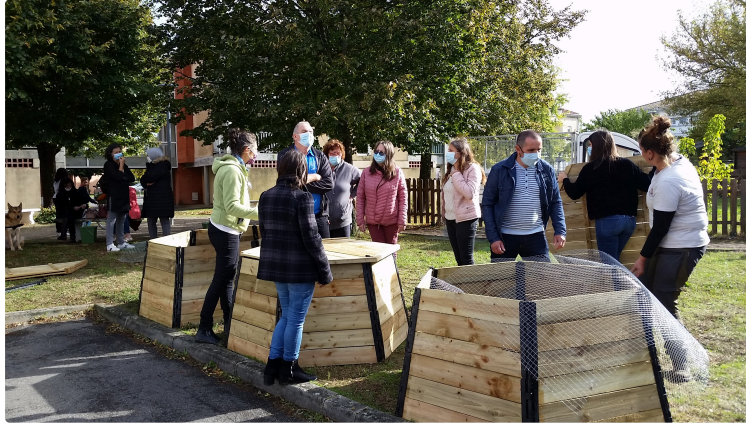
Installation de composteurs collectifs à la cité de la Vierge
