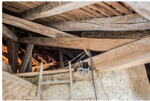
Aspect actuel de la charpente
