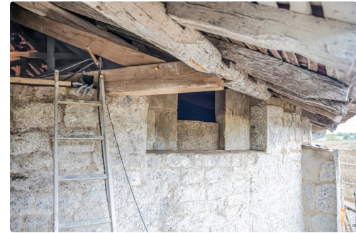
Une vue de la charpente restaurée
