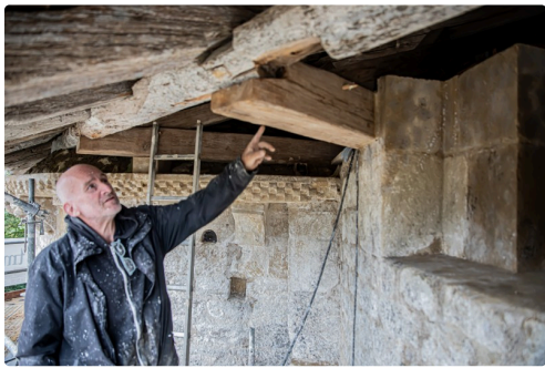
Cyrille Fourest montre la charpente rénovée
