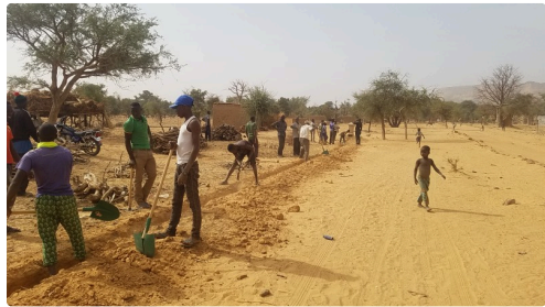
Creusement d'une canalisation - Photo communiquée par Patrick Robert
