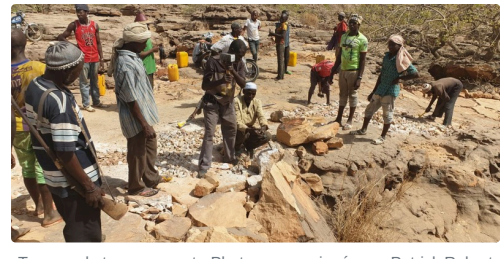
Travaux de terrassement - Photo communiquée par Patrick Robert
