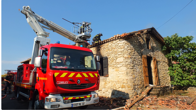
Une maison détruite par le feu
