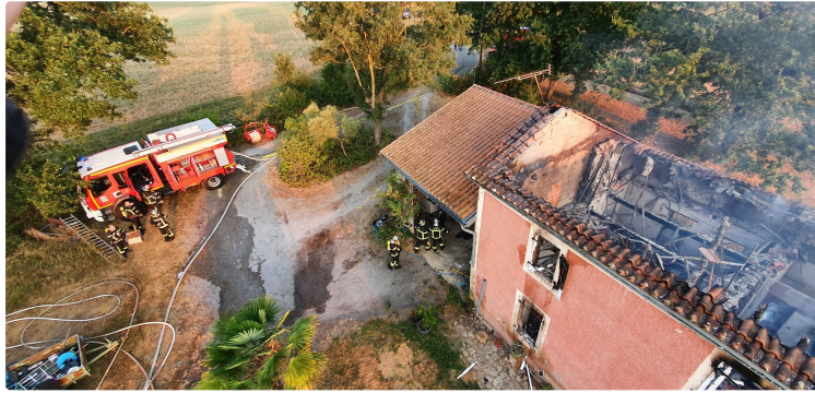
Une maison détruite par un incendie
