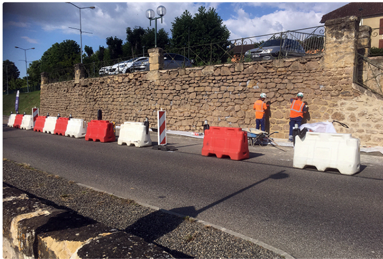
Travaux RN 21 : mur de soutènement de la place Noulens
