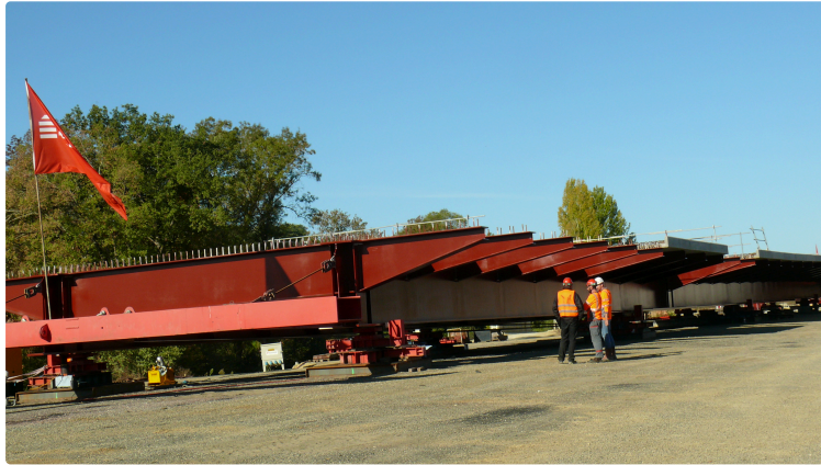
RN 124 : le chantier de la déviation de Gimont redémarre le 14 mai
