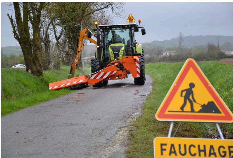
Reprise des travaux d'entretien des routes départementales
