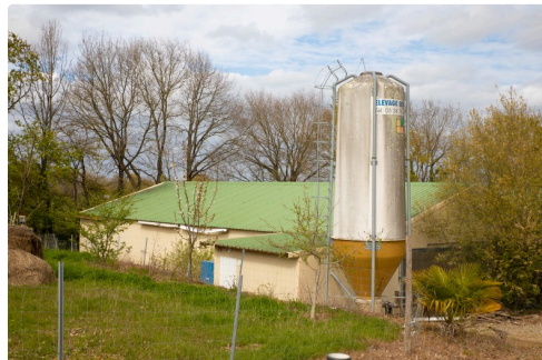
Le bâtiment d'élevage
