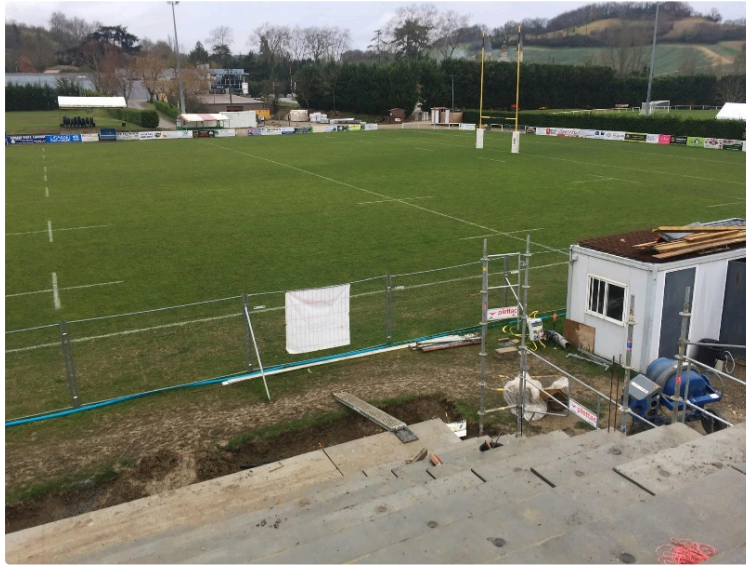
Tribunes de rugby : les travaux avancent
