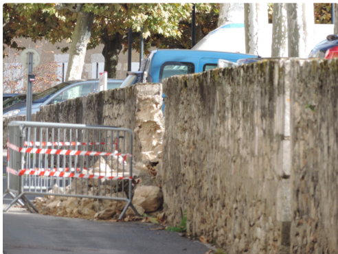
L'urgence des travaux est une réalité
