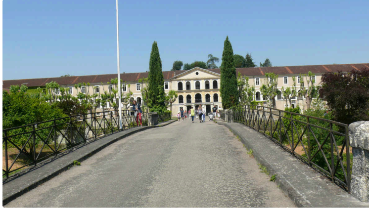
Réhabilitation de la caserne Espagne
