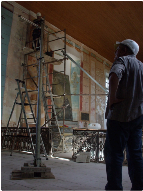
En cours de rénovation
