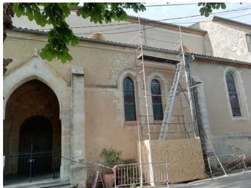
Échafaudage à l'extérieur de l'église pour monter sur le toit afin d'atteindre le vitrail.
