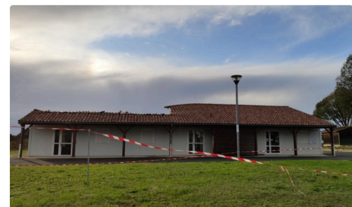
L'accès reste interdit au public
