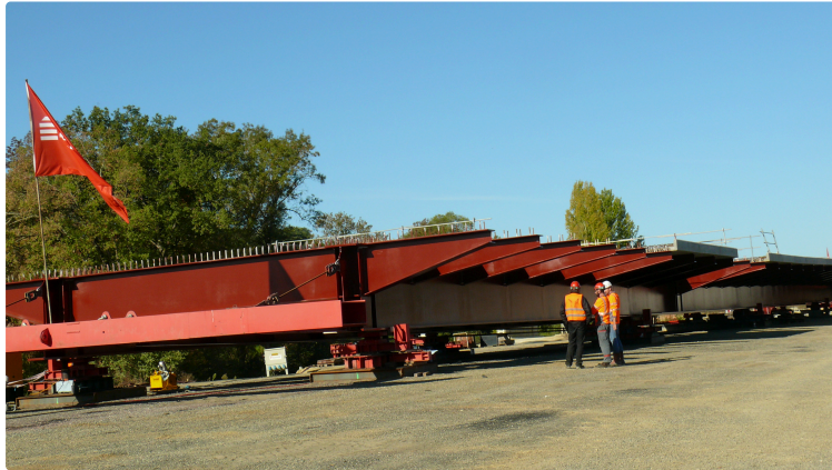
Déviations de Gimont : fin des travaux 2022
