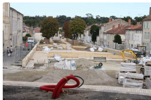
Le chantier de réaménagement des promenades est en cours.
