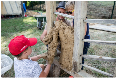
Les bâtisseurs au travail
