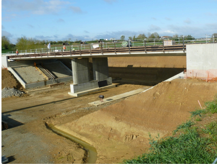
La RN124 pas d'excès de vitesse dans les travaux
