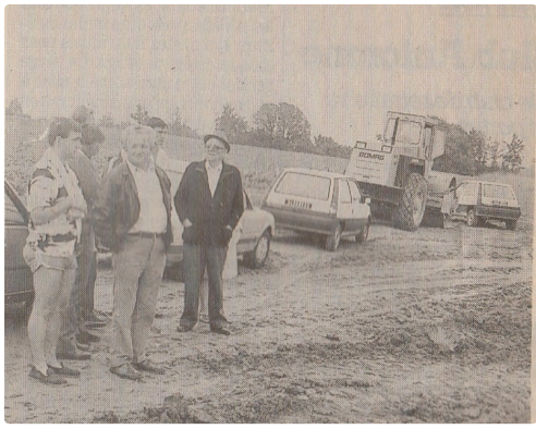
Suivi des travaux par Marc Castex et les responsables de la CACG, en août 1989
