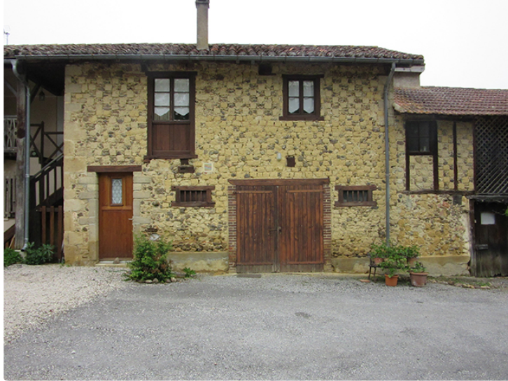
"Ces curieux murs en damiers de l'Astarac et du Magnoac"
