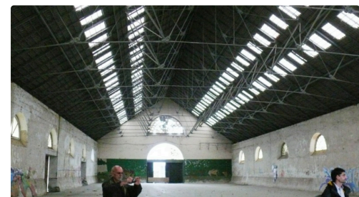
Le bâtiment qui accueillera l'école d'infirmière.
