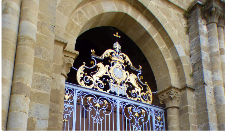
Restauration du beau portail de l'église Notre-Dame
