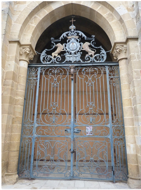
avant restauration photo année 2016
