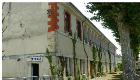
Un des onze bâtiments à réhabiliter.
