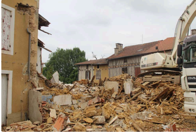
Les gros travaux ont commencé
