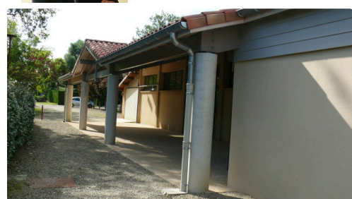
Agrandissement de la salle polyvalente par une couverture extérieure de 150 m 2 .
