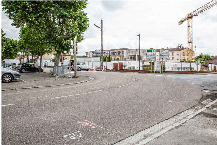
Trois mois de travaux pour le giratoire de l'hôpital
